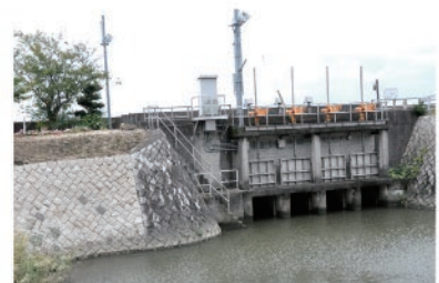
南蛮樋/陸側に南蛮樋門(遮蔽板を上下に動かす)、海側には唐樋門(遮蔽板を海水圧で動かす)となっていて機能が比較でき、昔は石門の板戸でした。
